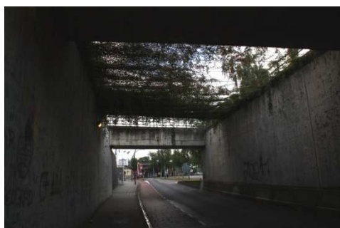
14. Licht aan het einde van de tunnel
